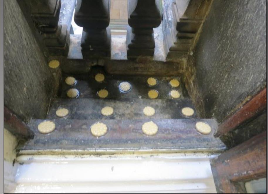
Auf der 3. Etage, wurden die Balustraden und der Boden des Balkons in den nördlichen Aussparungen mit 小島 *Bird Free* behandelt. (Da der Boden als Nistplatz genutzt wurde, wurden dort Schälchen in einem Abstand von 15cm aufgestellt.)
