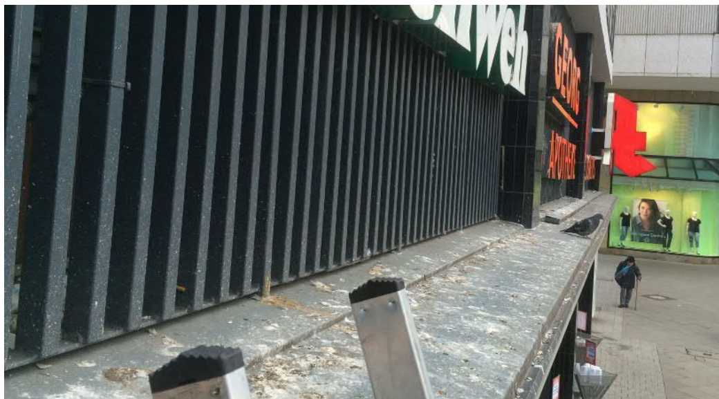
Zustand vor der Installation des Bird Free Vergrämungsgels
