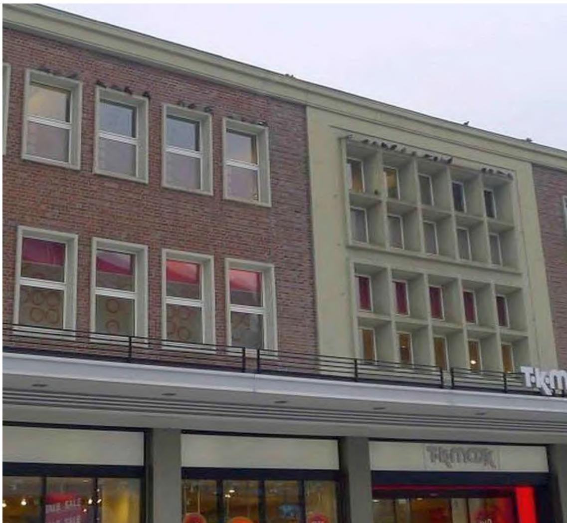
小島 Bird Free Gel: Montage an Dachkanten und Attiken
