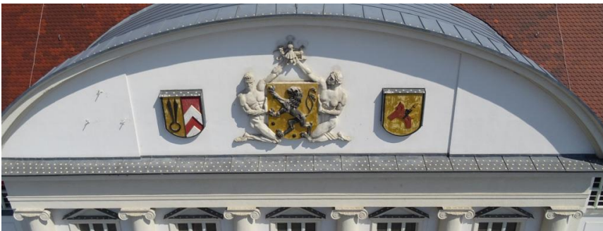
Denkmalgeschützte Fassade: Bird Free ist von unten nicht sichtbar
