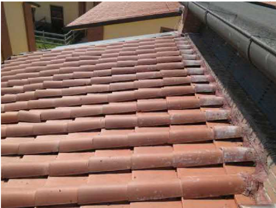
Bild 3. Süd-Dach nach der Reinigung.
