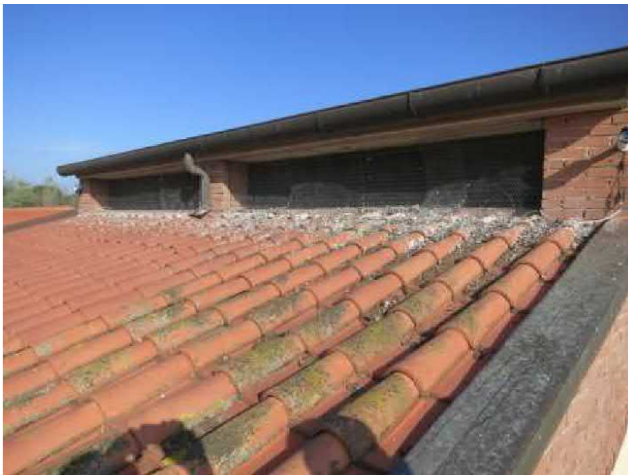
Bild 1. Süd-Dach vor Reinigung und vor dem Einsatz.
